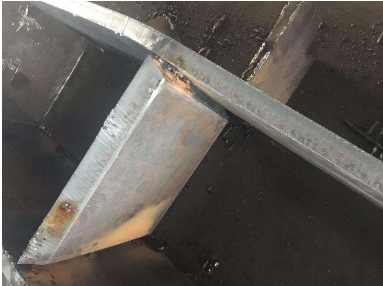
کارگزاری استیفر داخل ستون و عملیات مونتاژ
