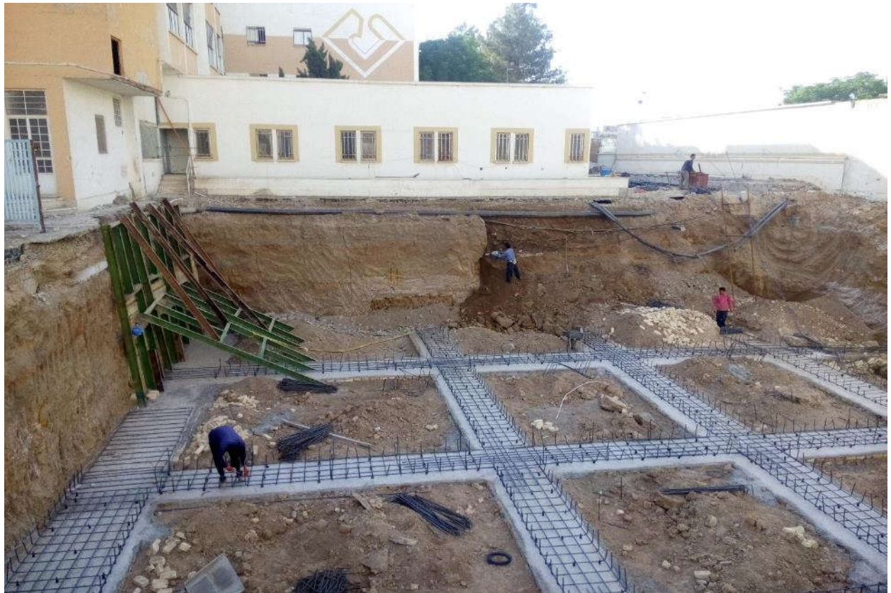
اجرای آرماتوربندی فونداسیون و خاکبرداری دیواره های گود به علت عدم گود برداری کامل
