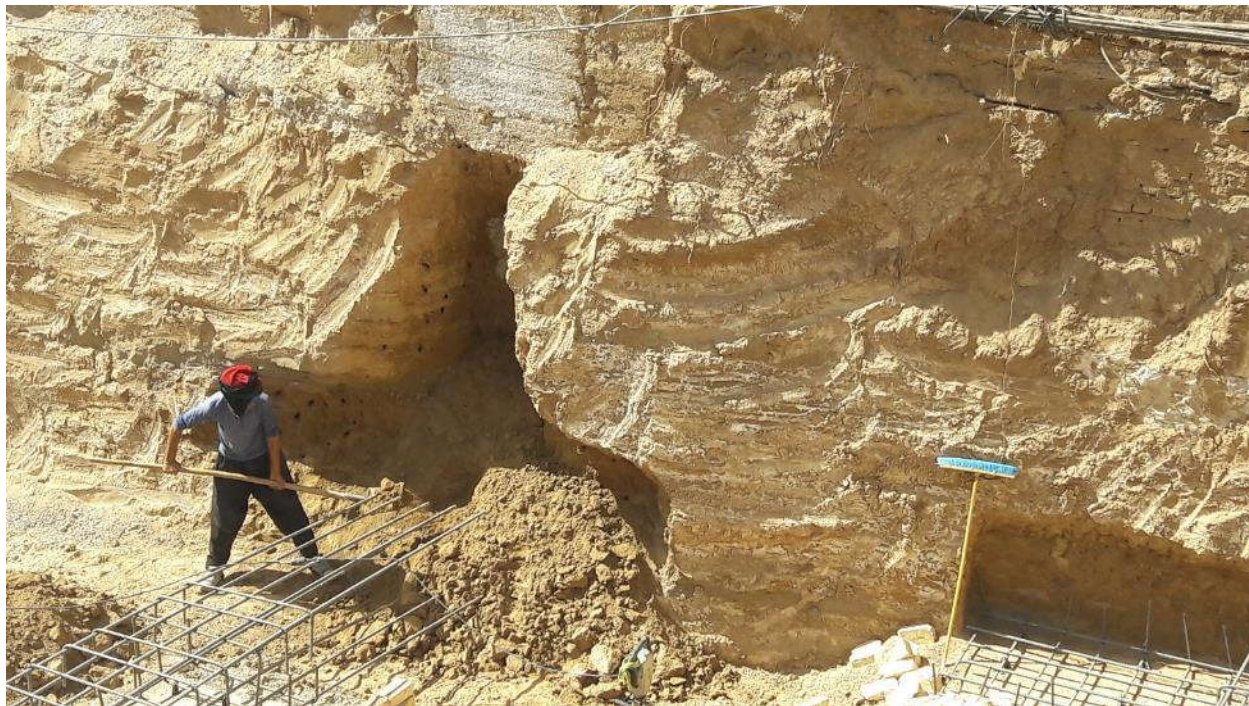
ادامه روند عملیات خاکبرداری به صورت دستی
